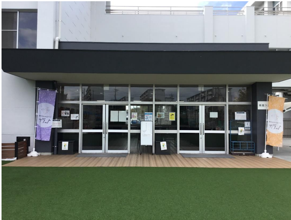
3. スロープを上りきると南館入口が現れます。
